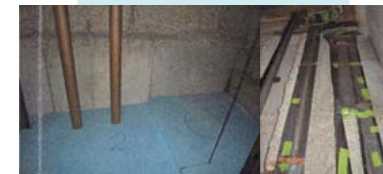
④かごの上にステージ設置 ⑤各階目張り養生 (内部)
