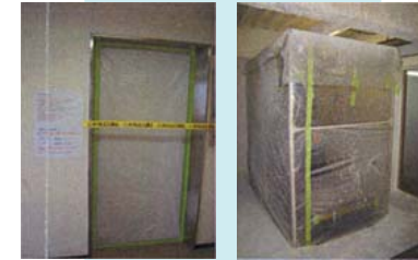
①各階目張り養生 巻上げ機隔離養生
