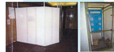
②仮囲い設置 ③セキュリティ設置
